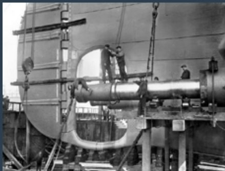
Lodní dělníci montují zadní hřídel pravoboku Titaniku
